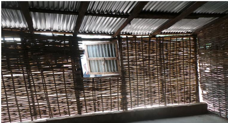
Interior de un aula. Paredes de bambú tejido, zinc para el techo y panel metálico para cerrar la ventana.
